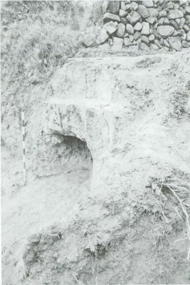
LÁMINA 2. Vista frontal de la estructura: *hypocaustum*, *suspensura* y *fornax* propiamente dicho.
