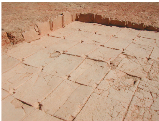
Figura 2: Detall del dipòsit de decantació V on s'observa la tècnica constructiva emprada. (Arxiu CODEX)
