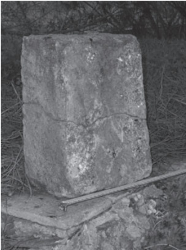
Figura 15. Dovella de terrissa, per construir arcs, de Sota la Timba del Castellot.
