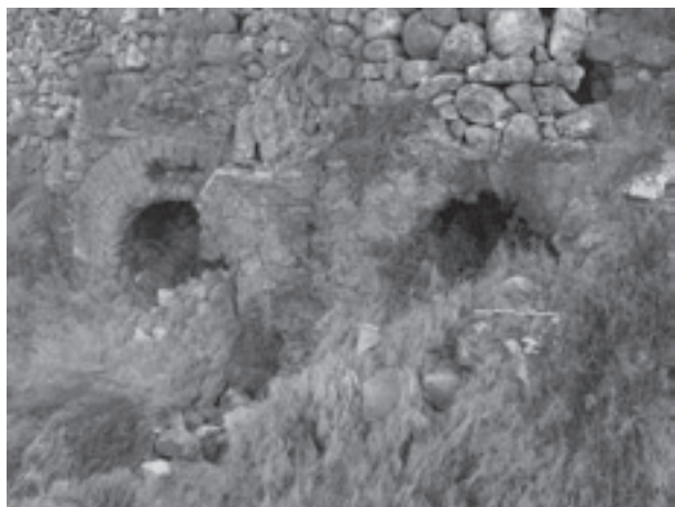
Figura 10. Les dues arcades de la cambra de combustió del forn de la Buada.
